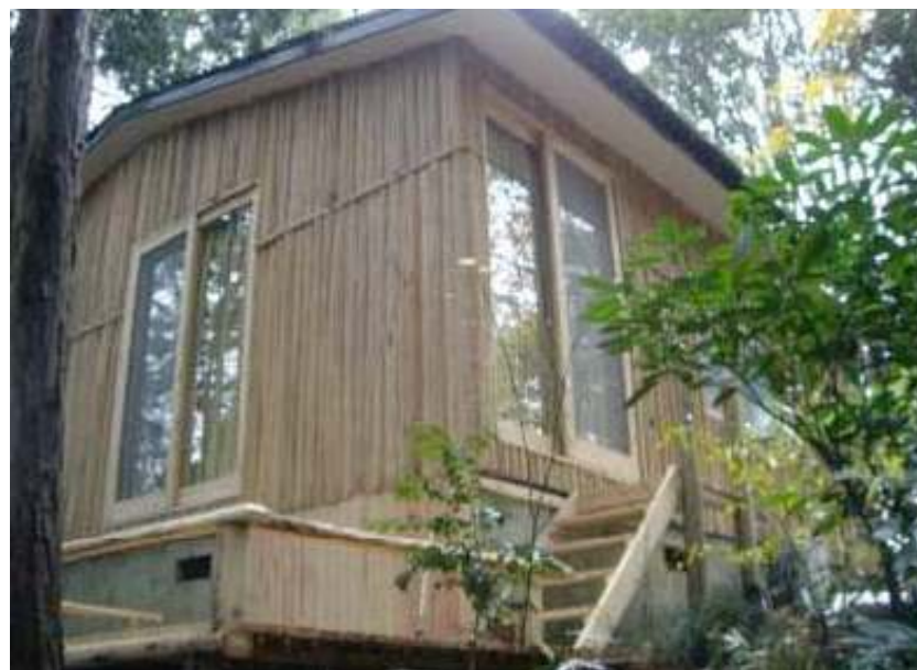
間伐材の活用。様々な提案を推進中。
